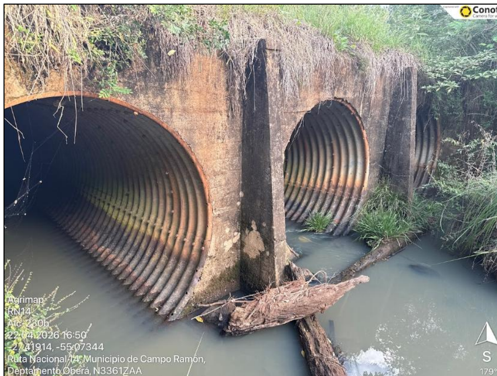
Figura 12. Alcantarilla – A° Ramón.
